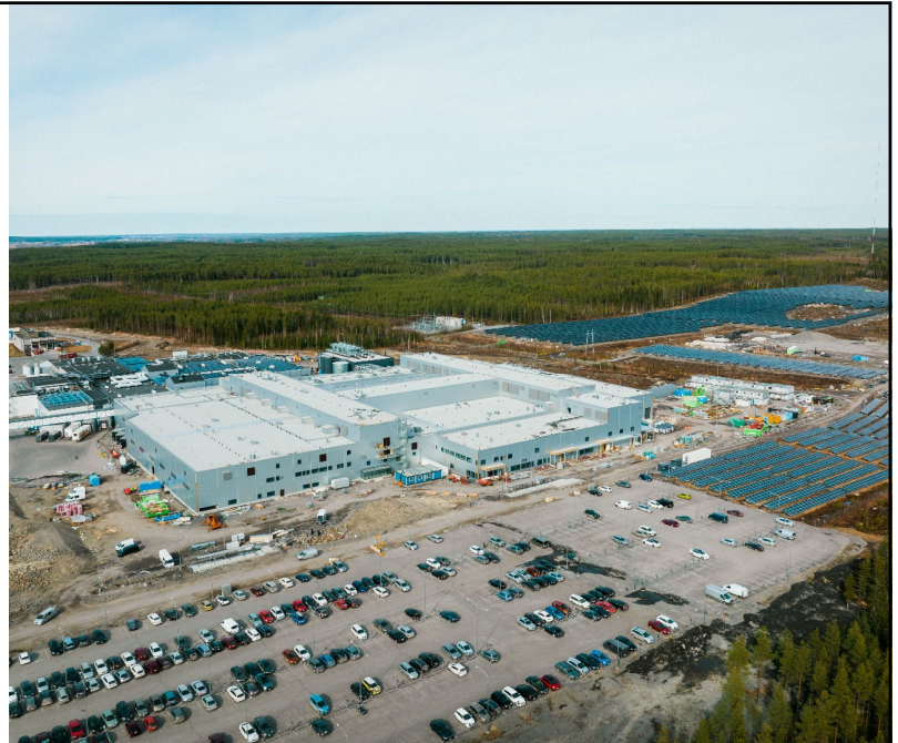
Nurmon siipikarjatehtaan työmaa 21.4.2023
